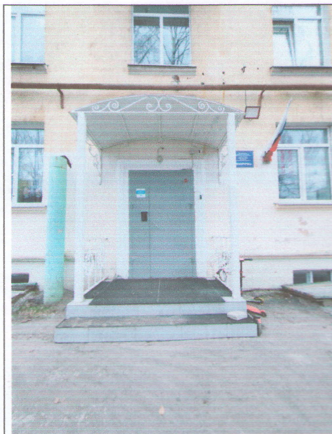
Подход к зданию
