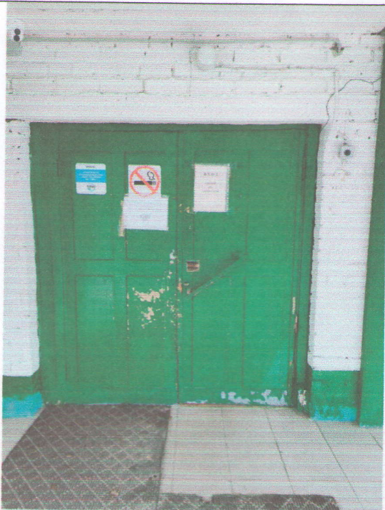
Распашные двери центрального входа
