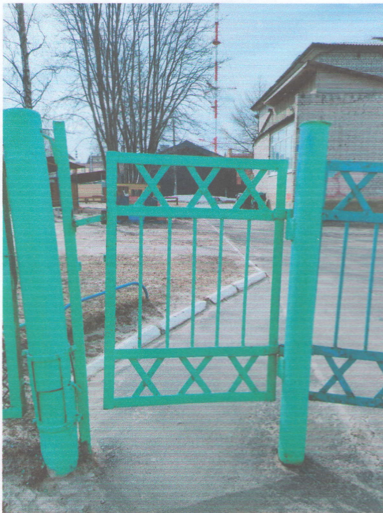
1. Подход к зданию
