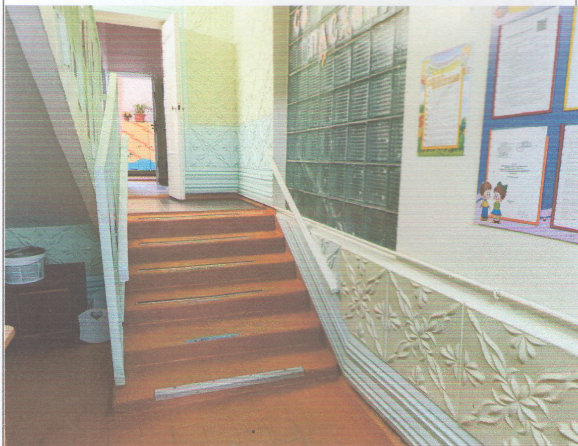
9. Лестничный марш на первый этаж с двухсторонними поручнями
