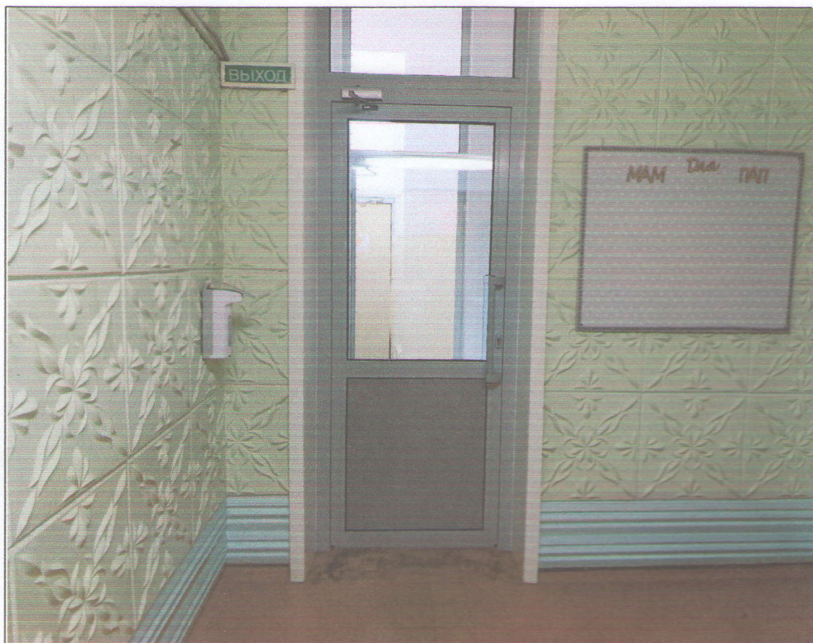
8. Двери центрального входа
