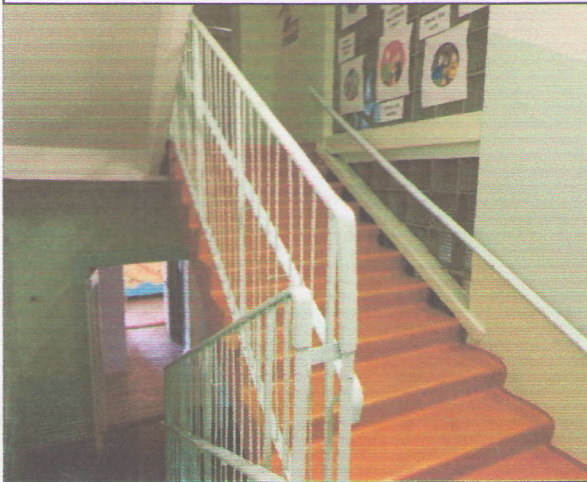
26. Межэтажная лестница с двухсторонними поручнями
